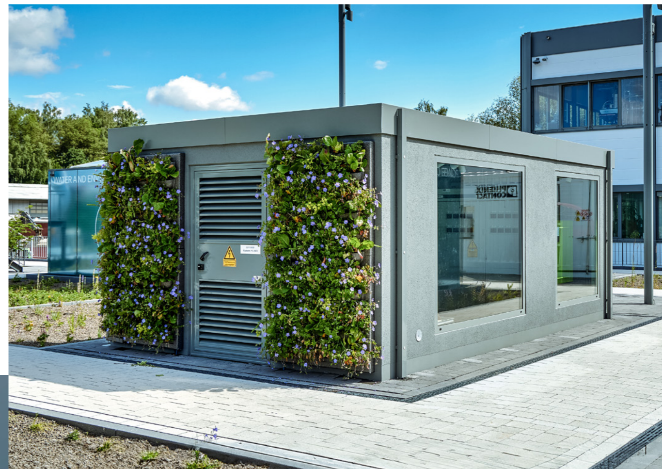
Die erste Trafostation aus Carbonbeton.
