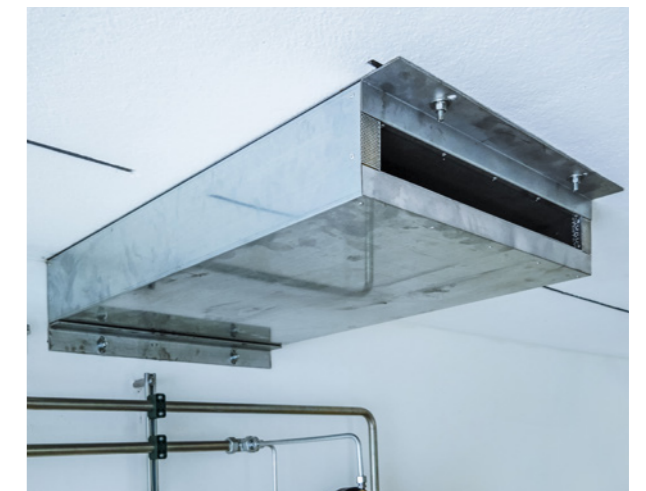
Schallgedämmter Blechkanal
