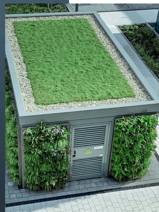
Die erste Trafostation aus Carbonbeton.
