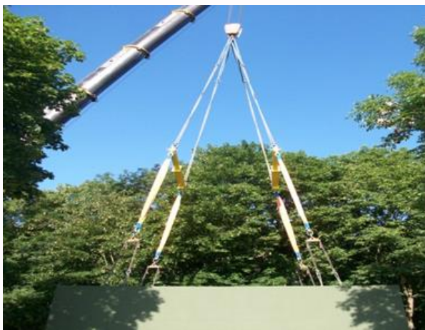
Abbildung 21: Spreiztraverse
