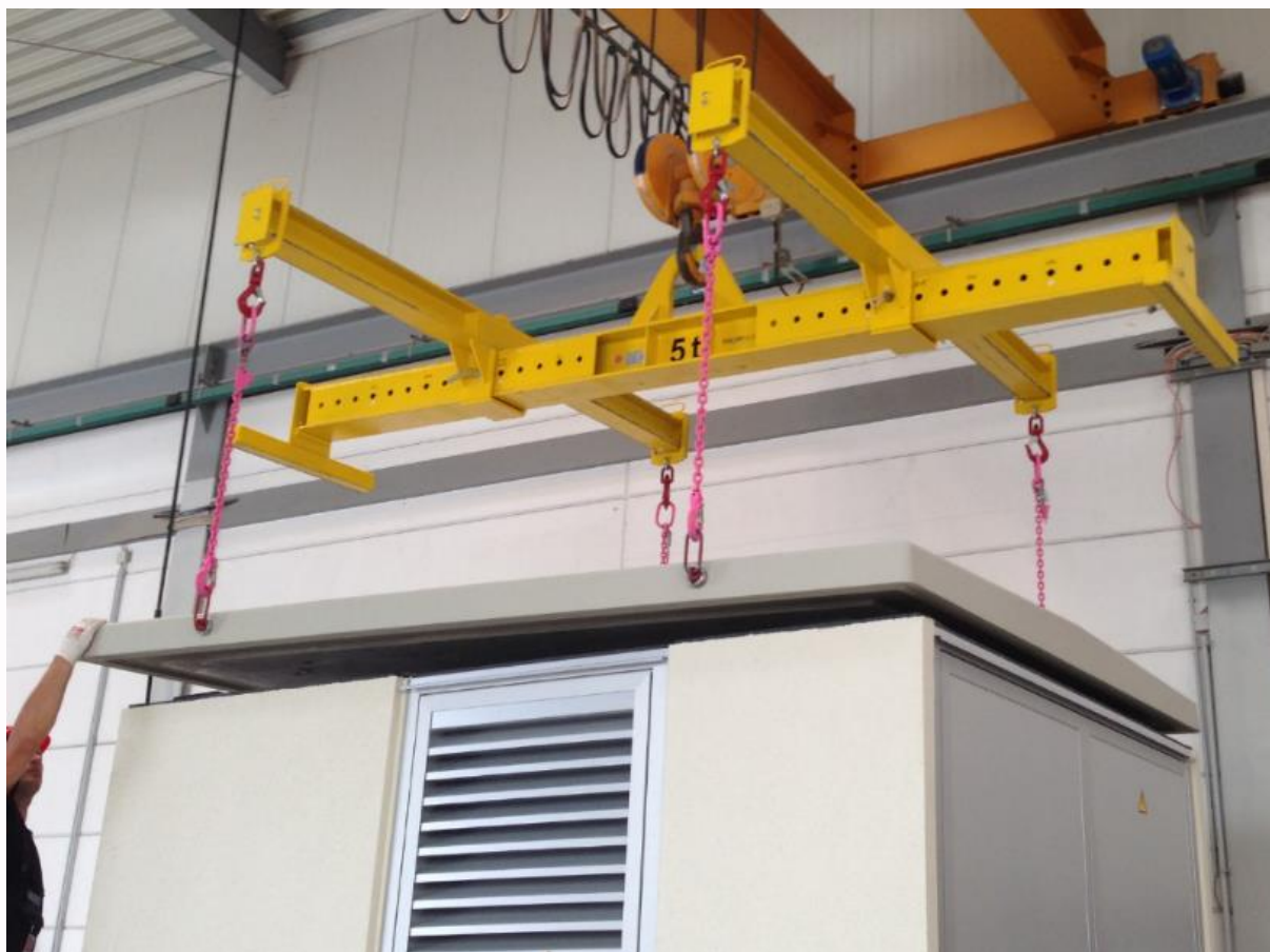
Abbildung 18: Wiederaufsetzen einer Dachplatte
