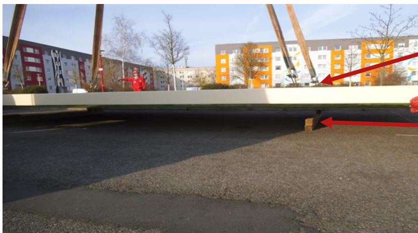
Abbildung 17: Zwischenlagerung einer Dachplatte
