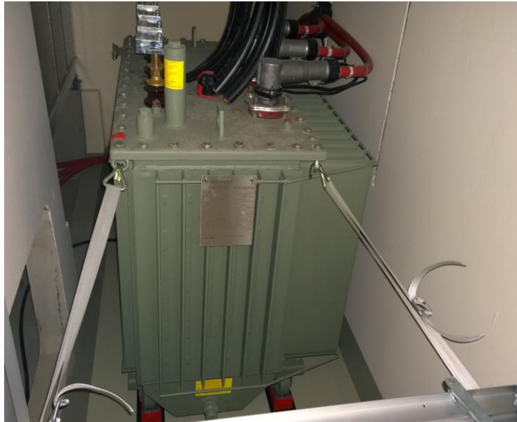
Abbildung 9: Beispiele für Ladungssicherung des Transformators in der ausgebauten Betonbau Raumzelle
